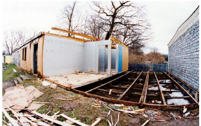
**Links: Der SRB sanierte mit viel Energie die Gebäudesubstanz. Hier Arbeiten an der Außenfassade des Kraftraumes! Rechts: Die völlig verschlissenen Baracken im hinteren Teil der Anlage wurden vom SRB abgerissen und entsorgt, auf die Fundamente acht Container gestellt, die mit einem gemeinsamen Dach versehen wurden und als Werkstätten und Lagerräume dienten.**
